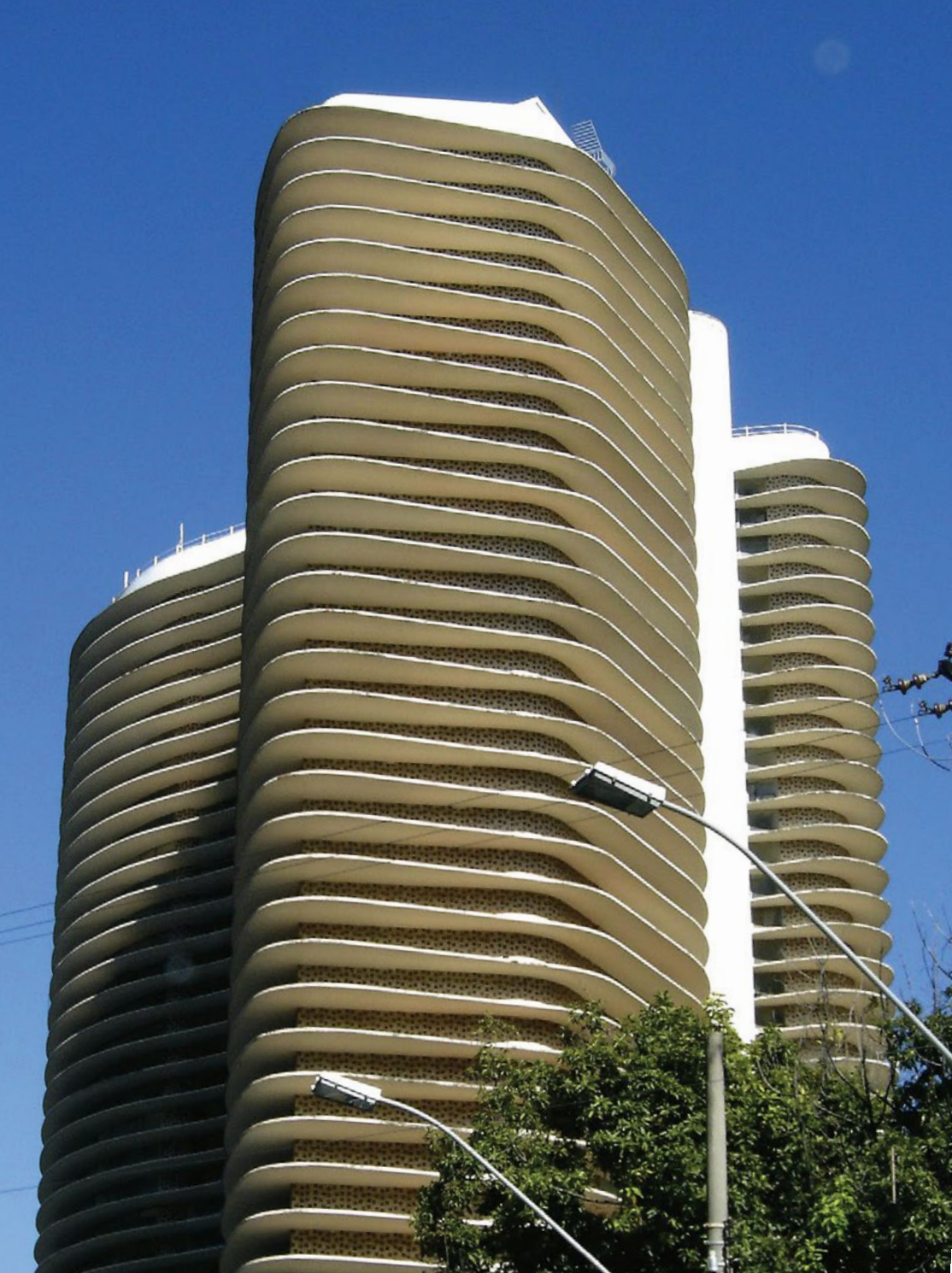
EDIFÍCIO NIEMEYER / PAULO ANDRADE
